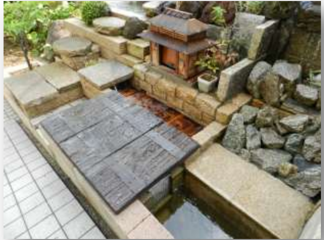
ポンプ室・貯水槽と配電盤（山門風模型）
