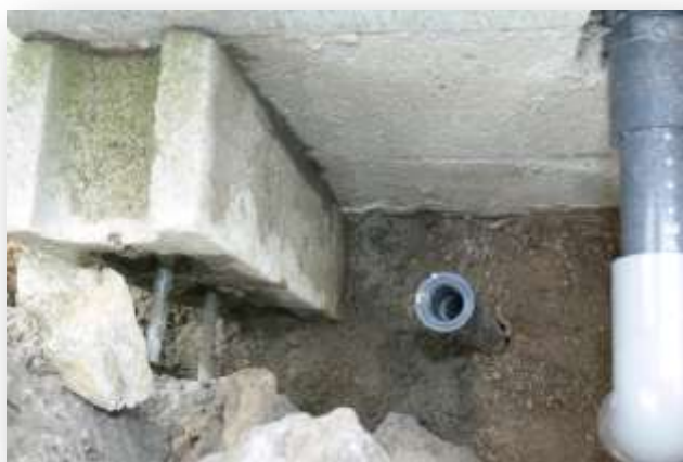
水循環の配管を施工
